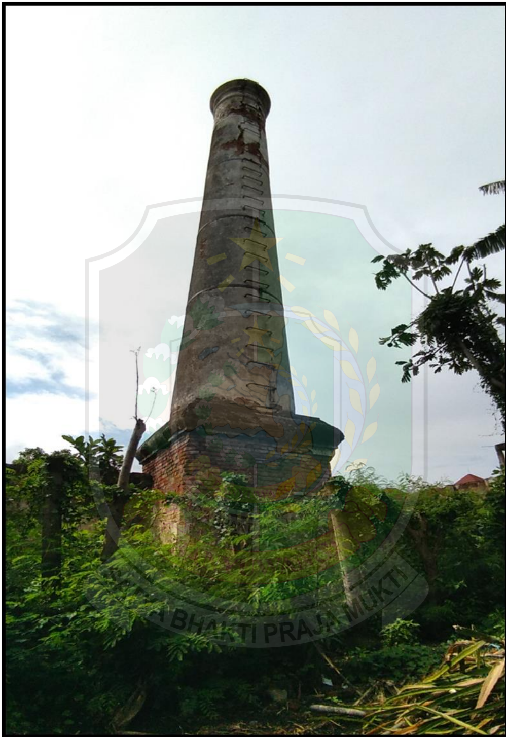
Gambar 4.20 Struktur Cagar Budaya - Cerobong Asap PT Pertani Sumber: Dokumentasi Bayu Ari Wibowo, 2020
